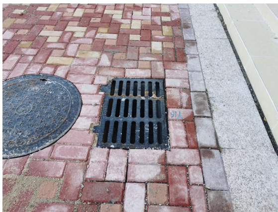
照片 19-22 雨水篦子照片
