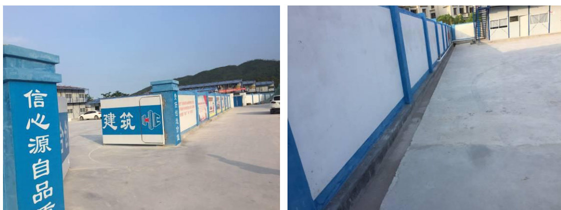
照片 11-12 施工营造区现状
