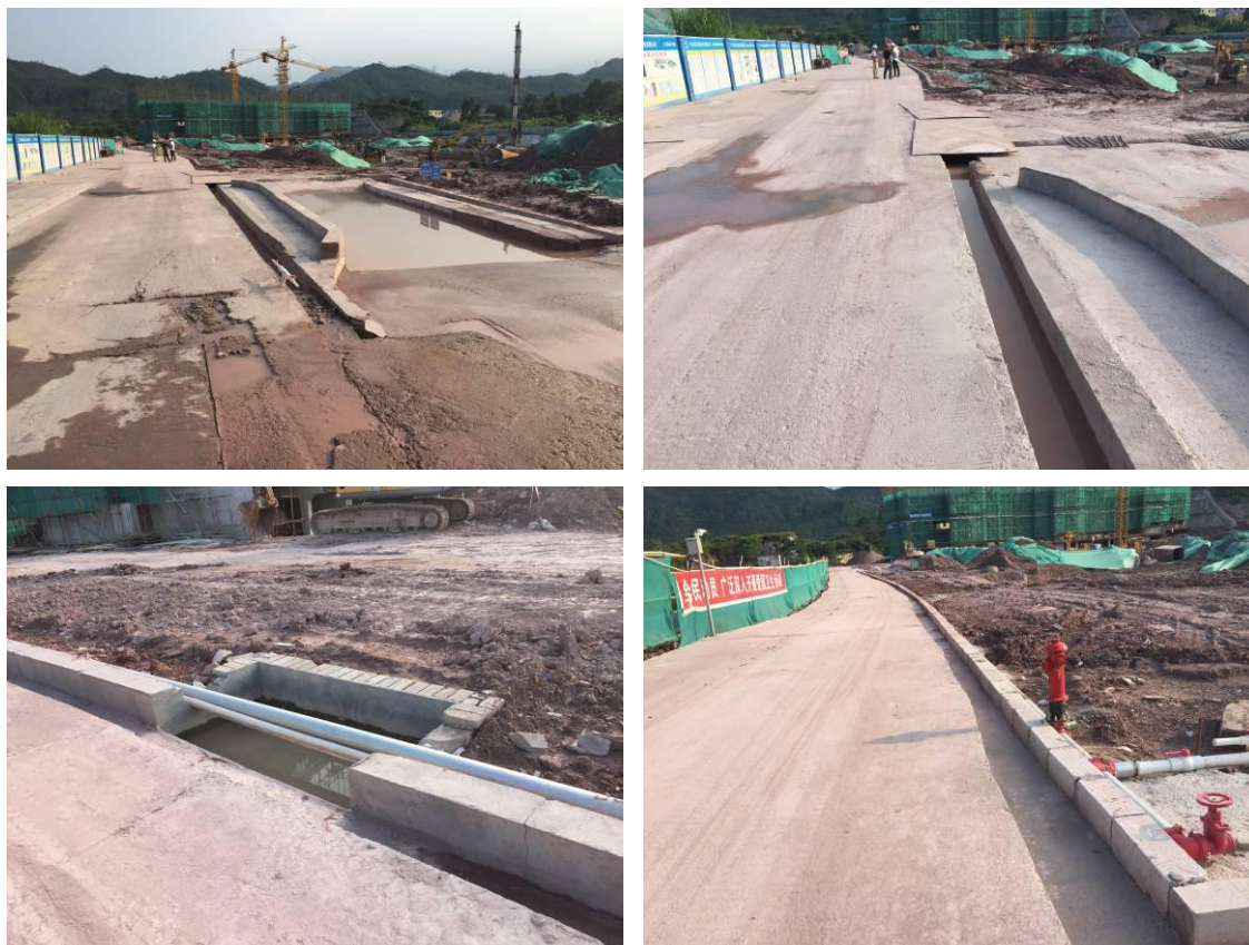
照片 7-10 场内排水沟、沉沙池及洗车池
